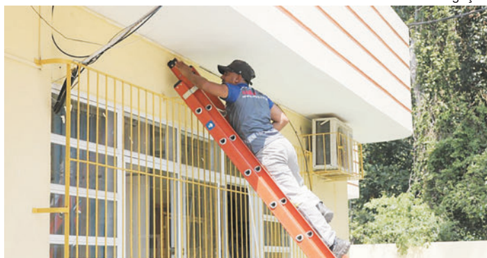
A instalação em todas as 94 unidades será concluída em novembro
