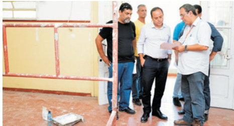
Rodrigo Neves visita obras no prédio em Pendotiba.
