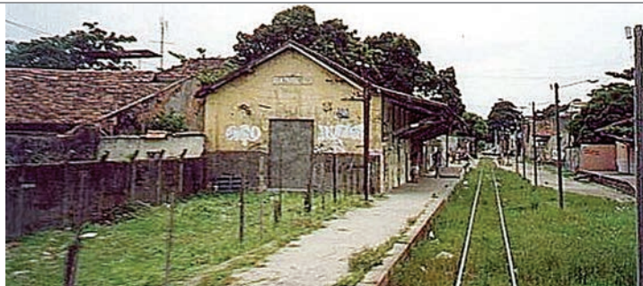
O início das obras começará na Estação do Barreto
